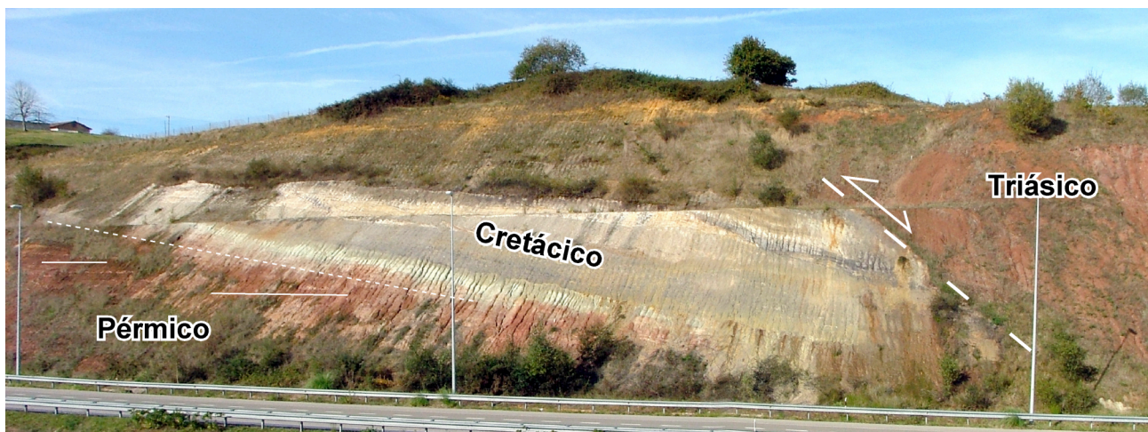
Fig. 9 Falla de Llanera en el talud de la autovía del cantábrico entre las localidades de La Secada y Lamasanti ( explicación en el texto ).
